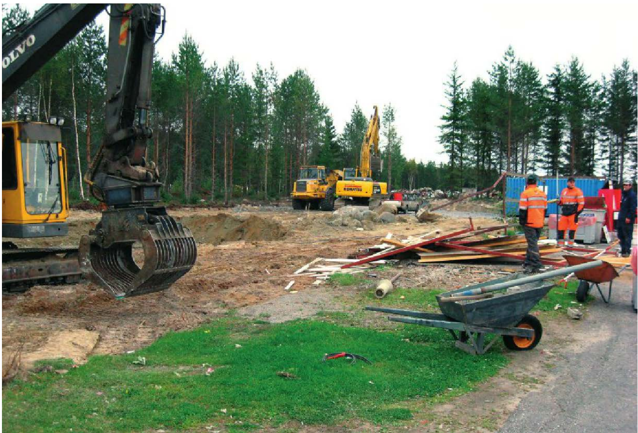
Pirilön hyötykäyttöaseman laajennustyöt Pietarsaaressa. / Utvidgningen av återvinningsstationen i Pirilö, Jakobstad.
