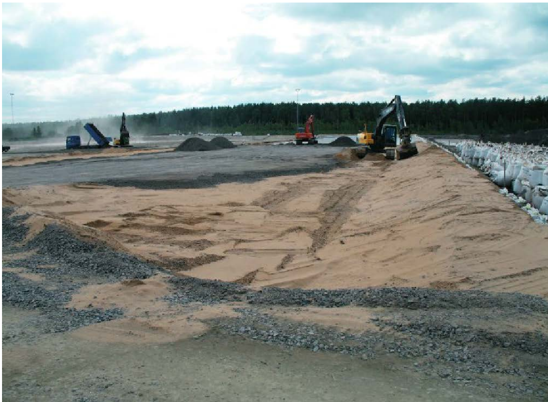
Uuden loppusijoitusalueen rakennustyöt täydessä vauhdissa. / Byggnadsarbetet på den nya deponin är i full gång.
